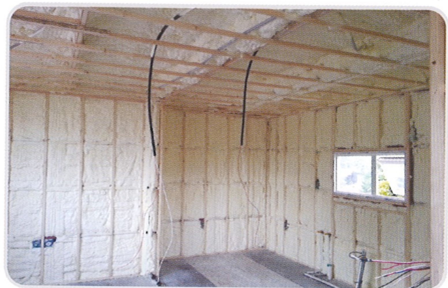
- 컨테이너 하우스 내부 시공 후
