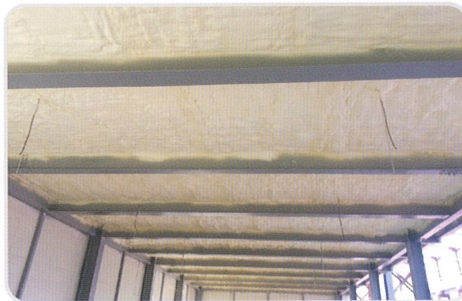
- 데크플레이트 시공 후
