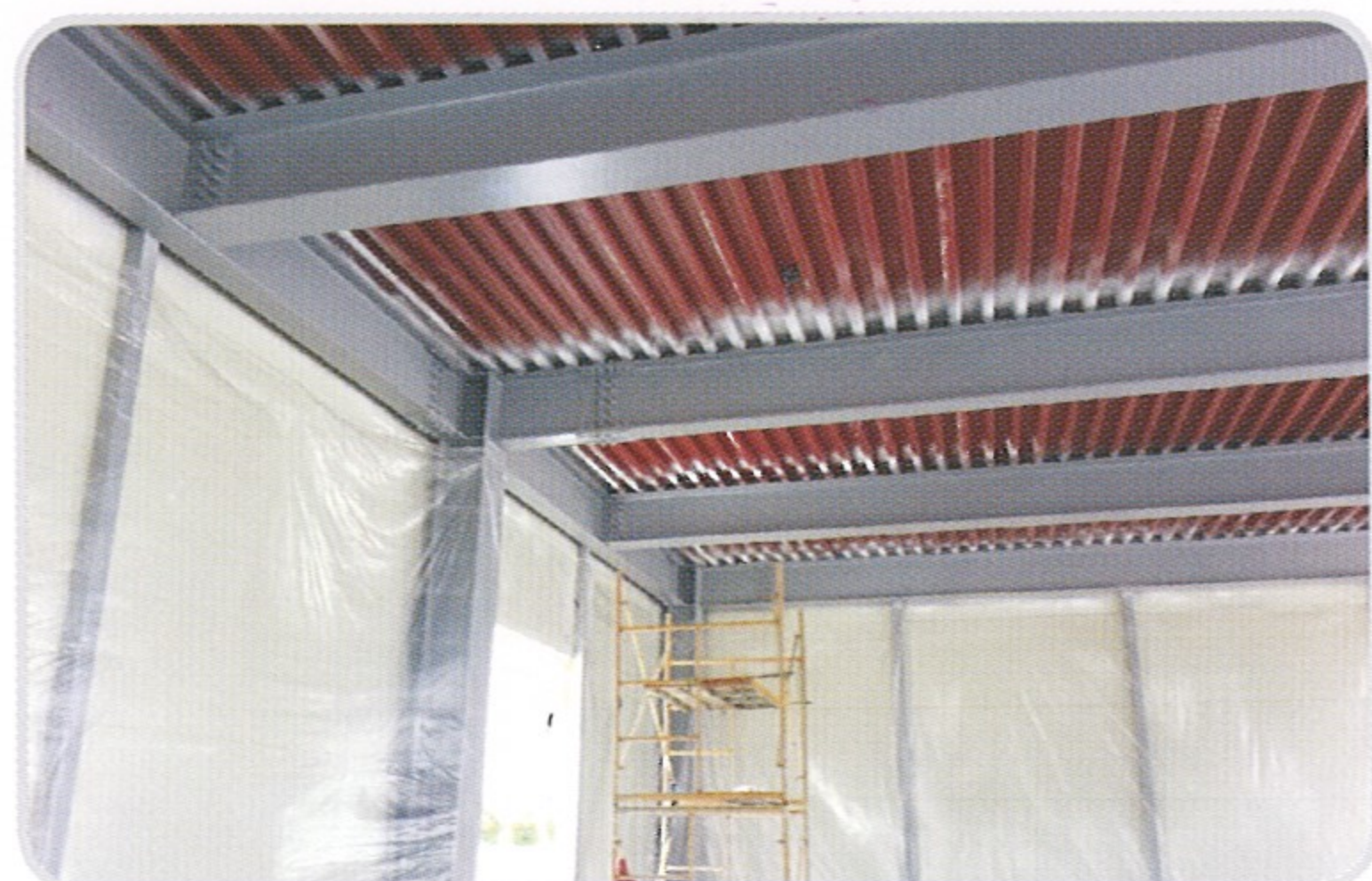
- 데크플레이트 시공 전
