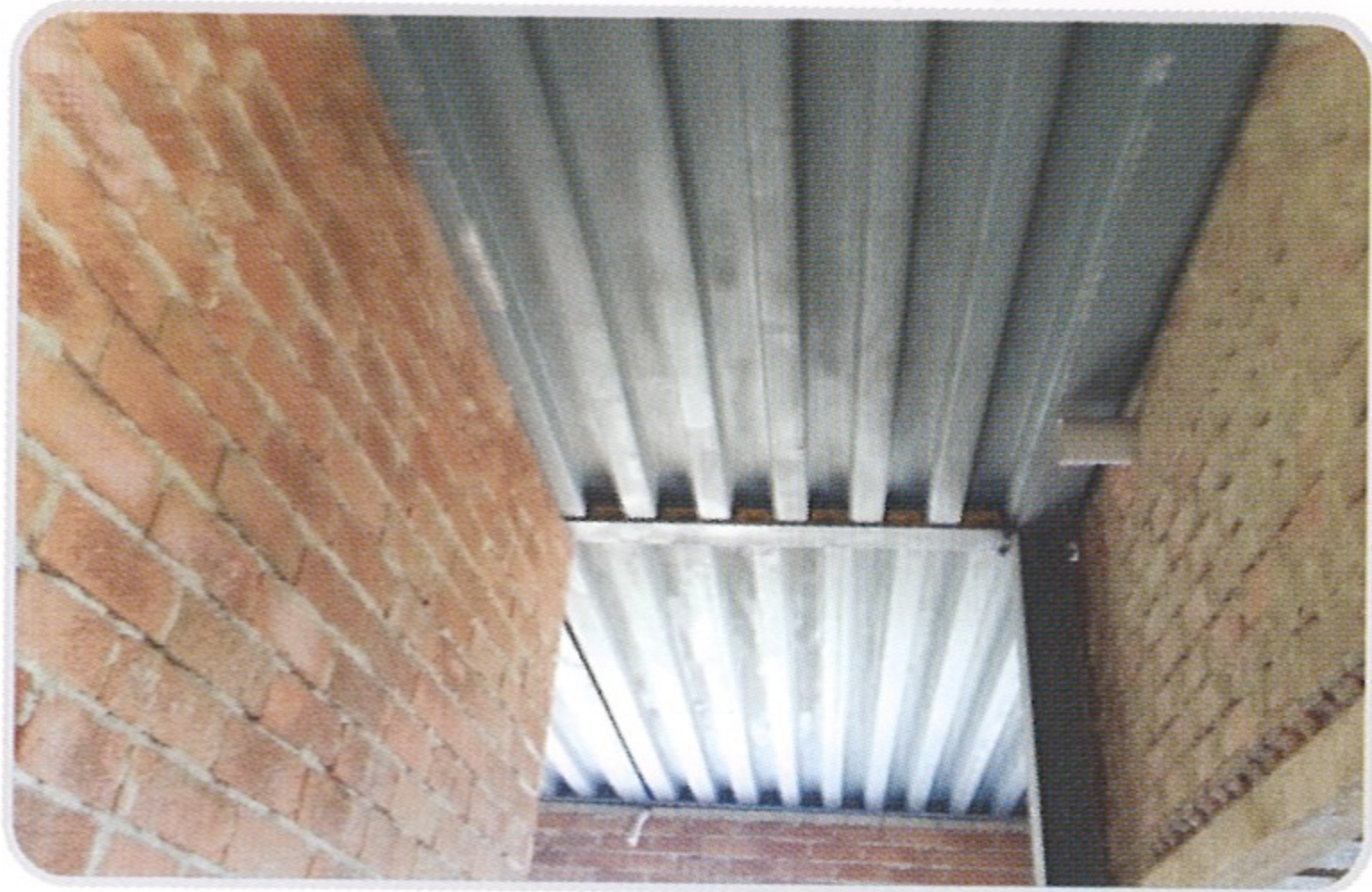
- 주택천정 시공 전
