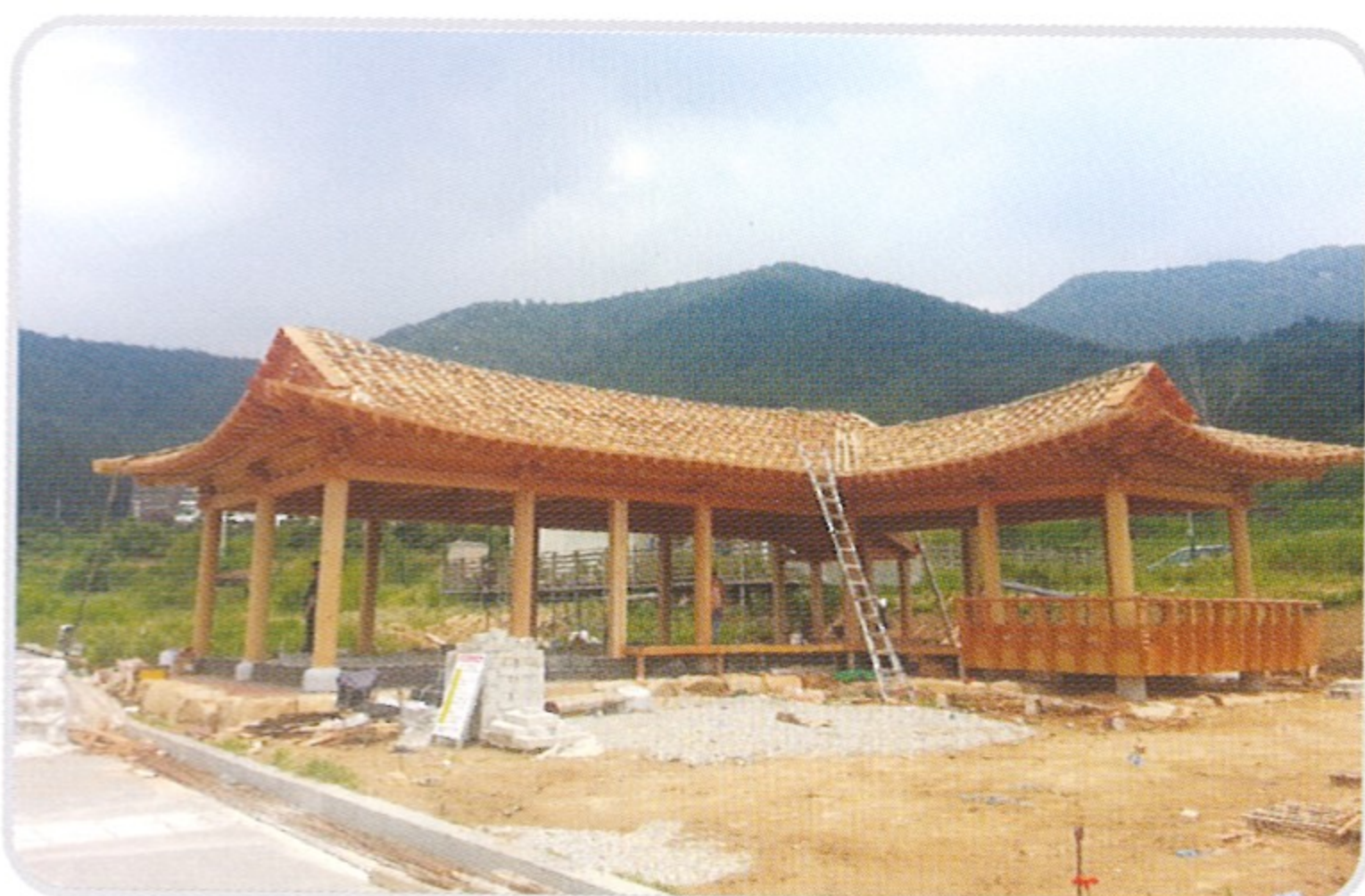
- 한옥지붕 시공 전
