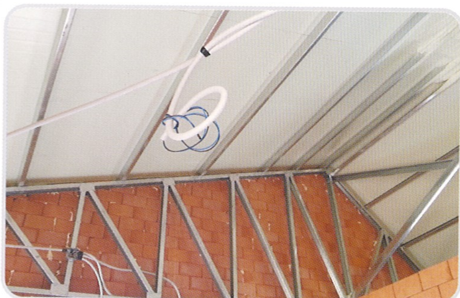
- 황토벽돌집 천정 시공 전
