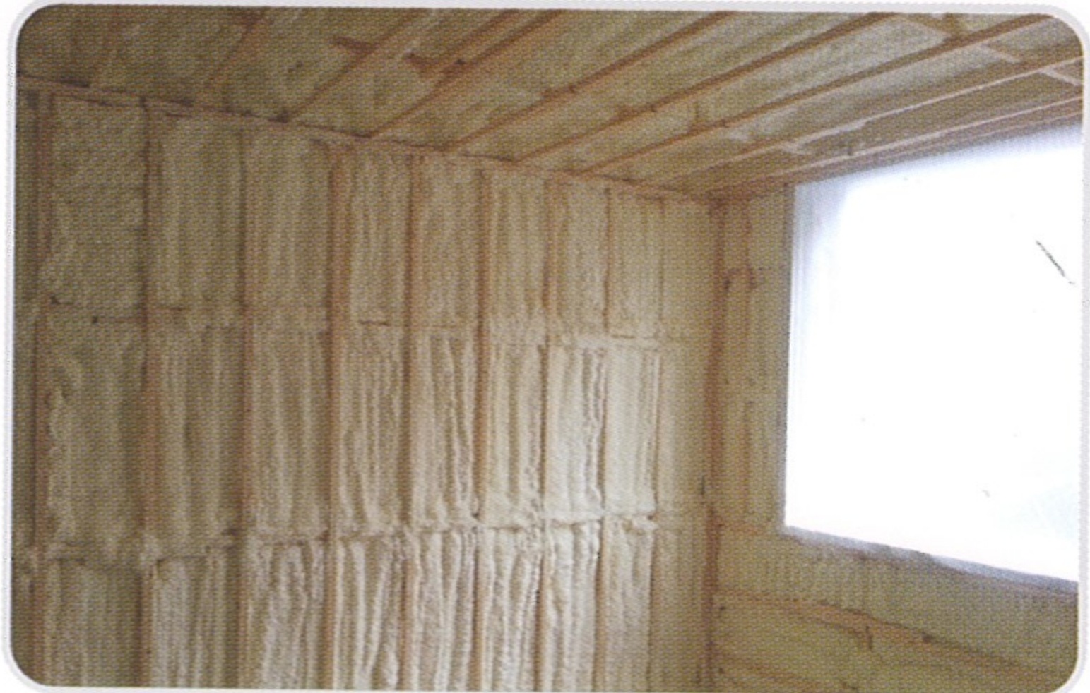
- 주택 리모델링 시공 후
