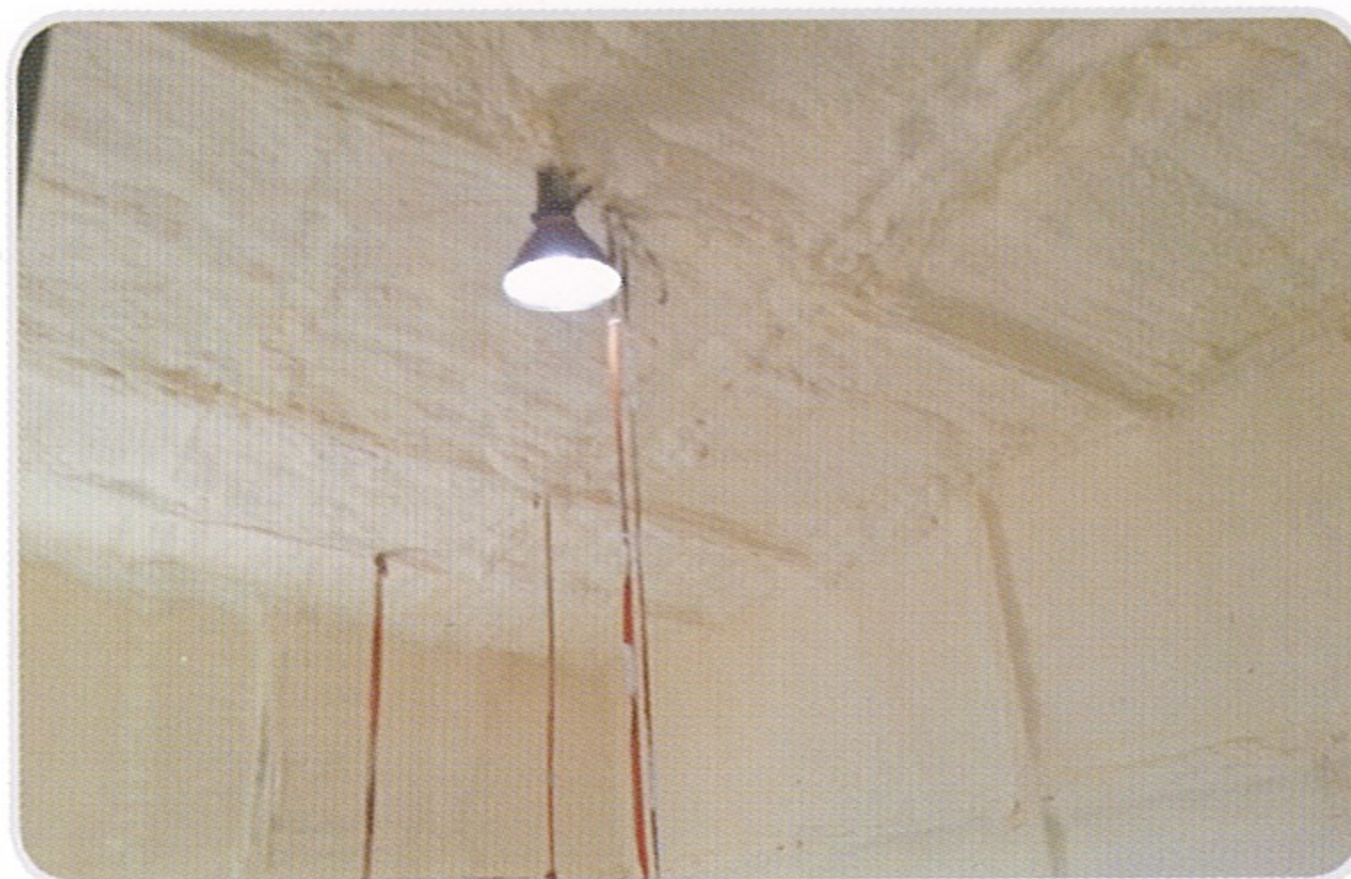
- 냉동창고 시공 후
