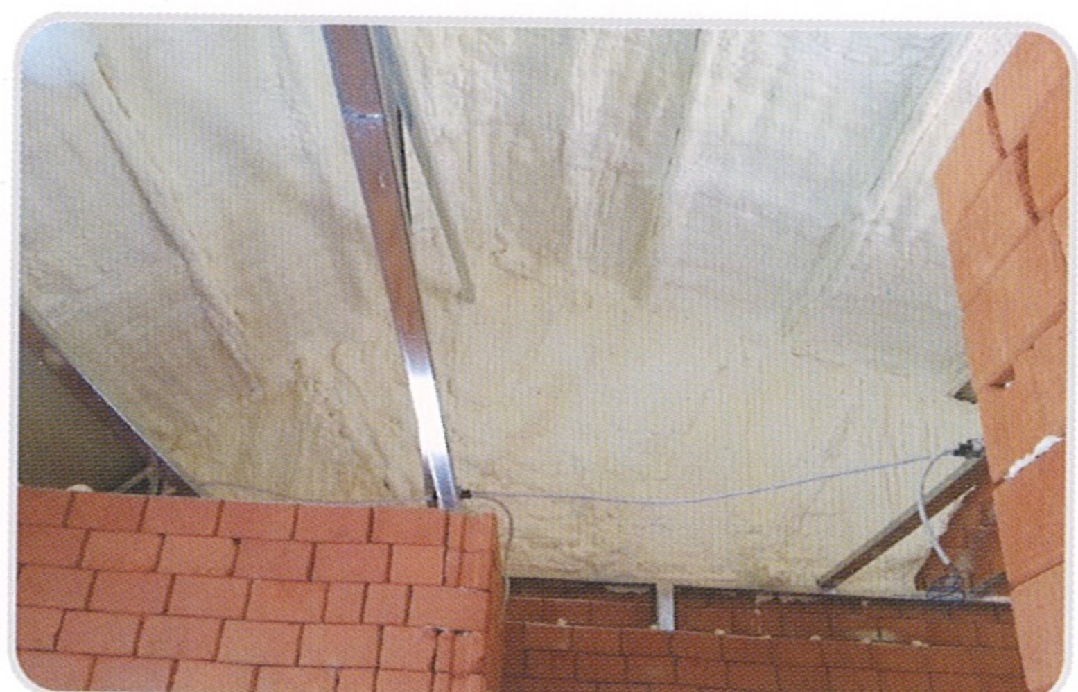
- 황토벽돌집 천정 시공 후
