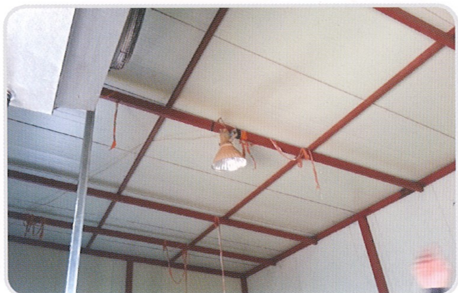
- 냉동창고 시공 전
