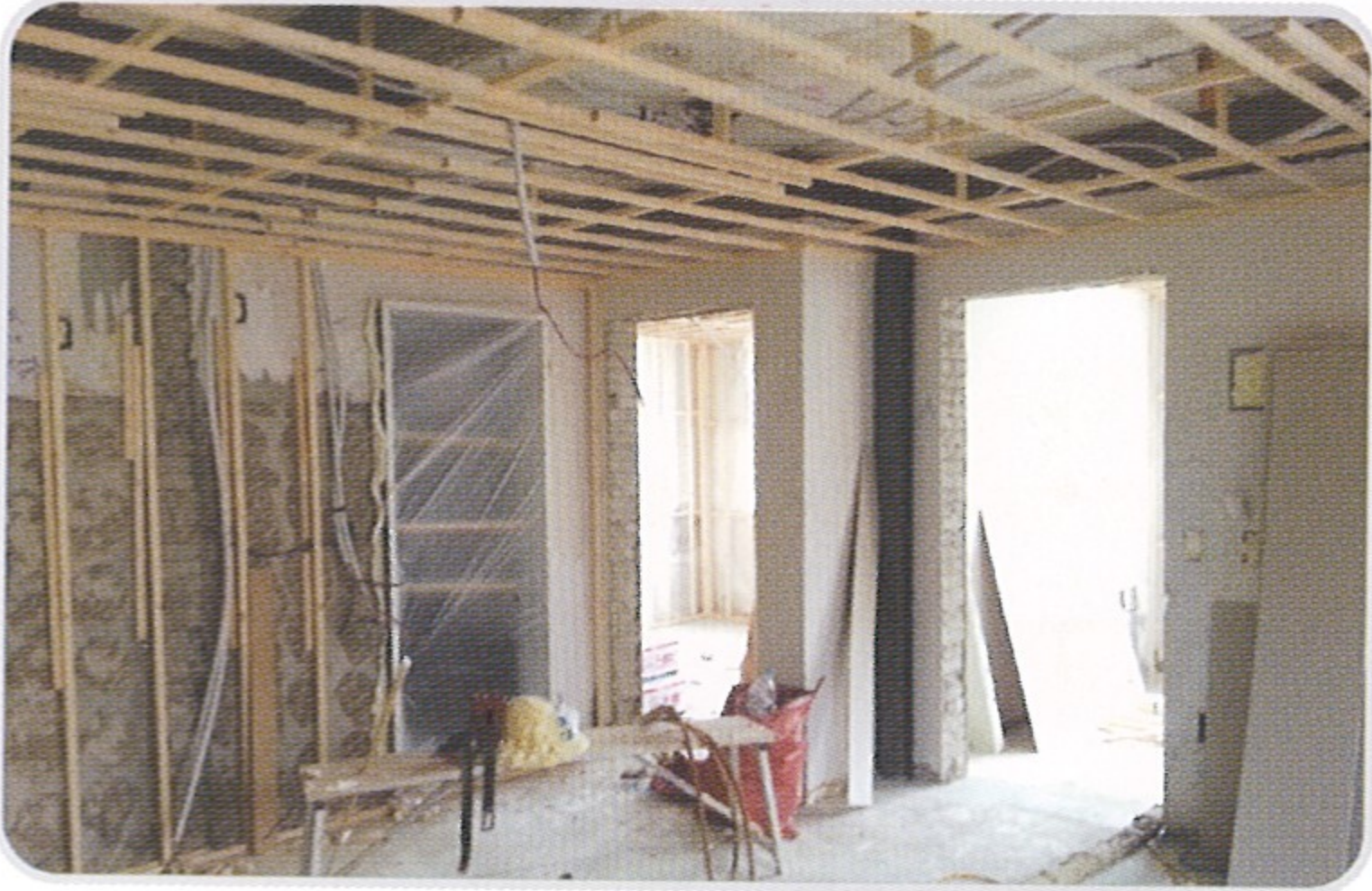
- 주택 리모델링 시공 전
