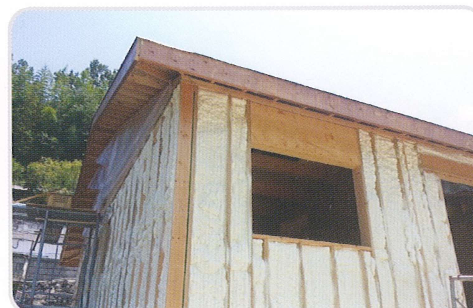
- 목조주택 시공 후
