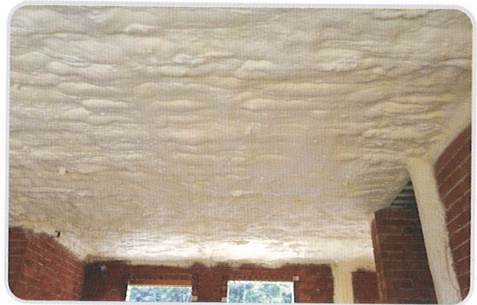
- 주택천정 시공 후
