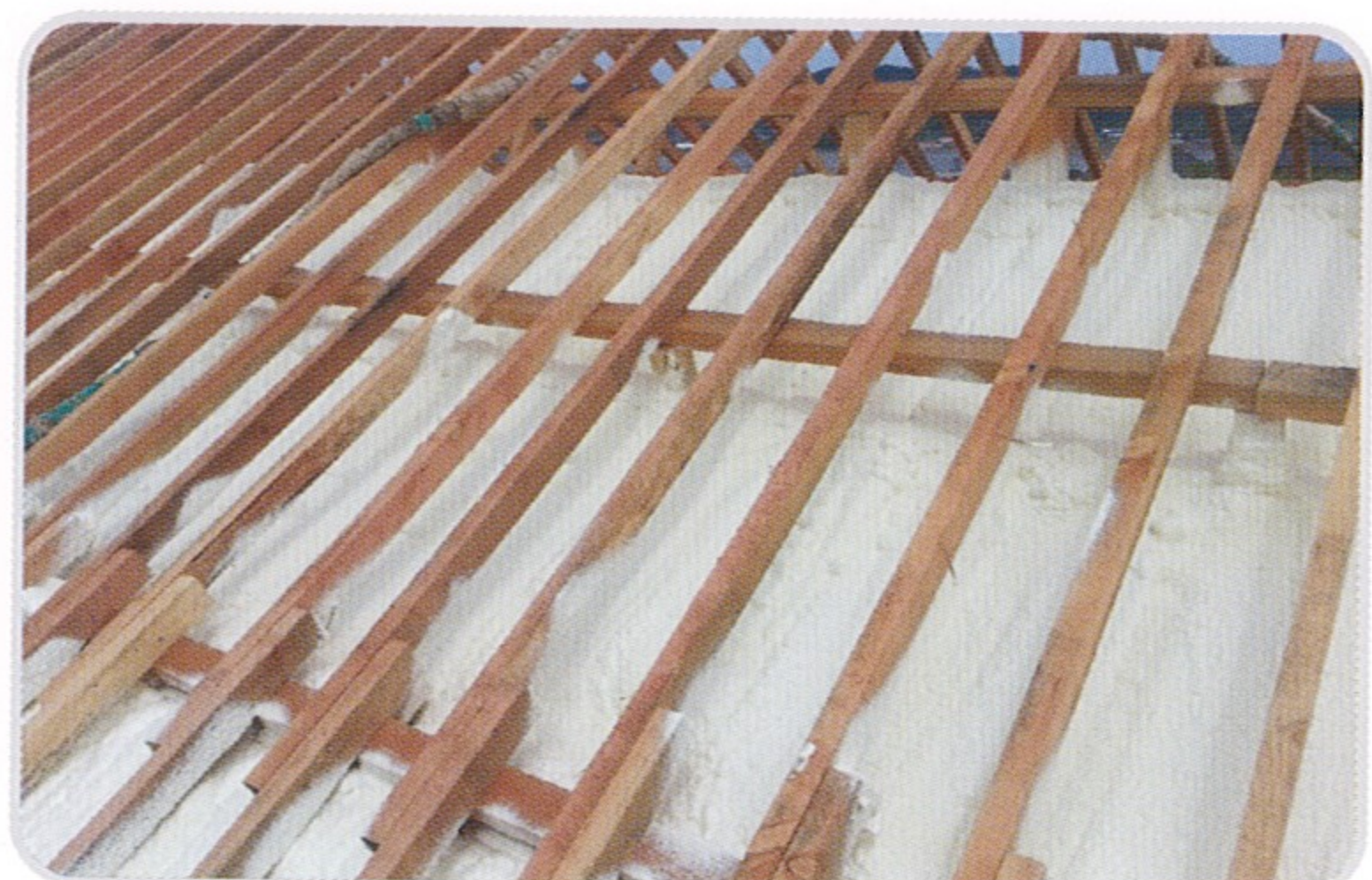
- 한옥지붕 시공 후
