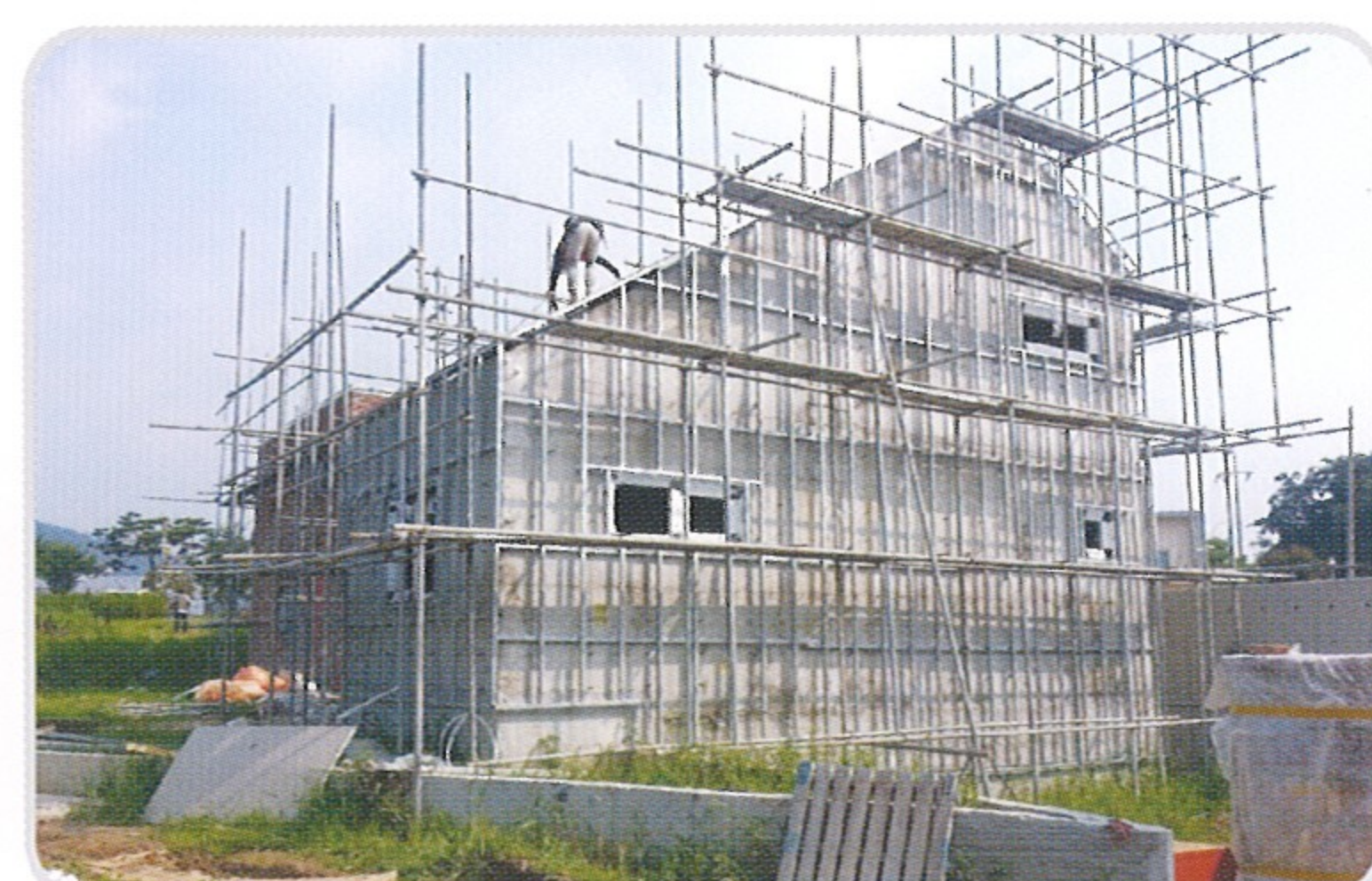
- 전원주택 외벽 시공 전
