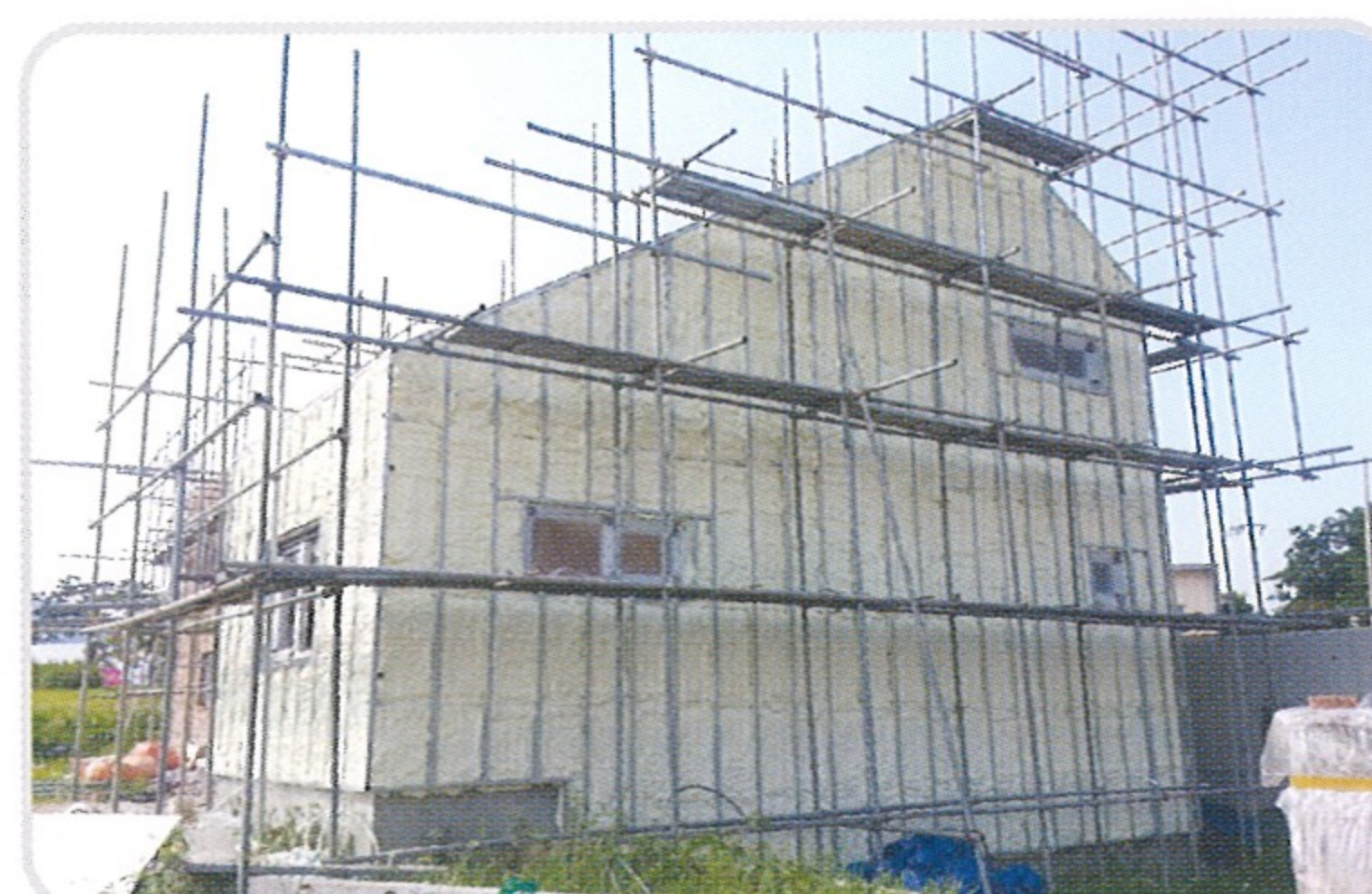
- 전원주택 외벽 시공 후
